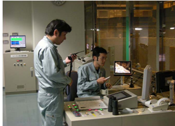
ごみクレーン室より状況確認中
