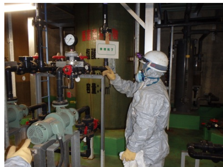
薬品漏洩対策訓練（平成 25 年 11 月 20 日）
